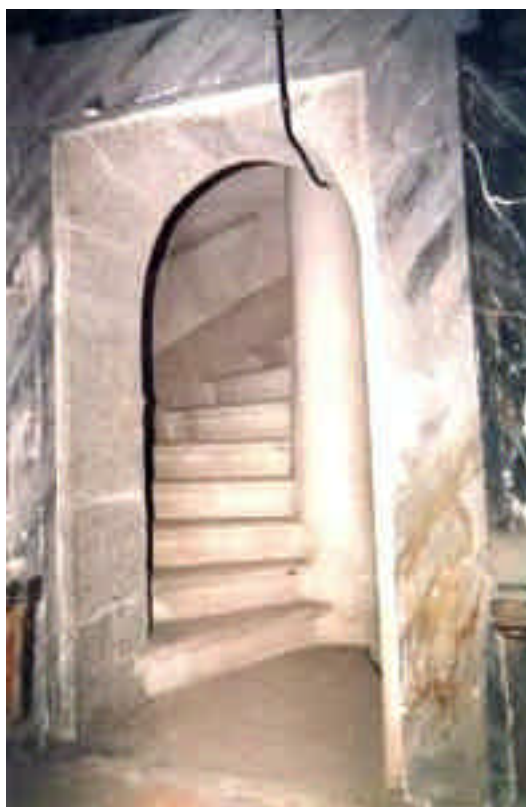
Lám. 1 y 2: Antigua escalera de acceso al Panteón desde la Basílica. En el siglo XVII se condenó con una bóveda semiesférica enyesada, donde aún pueden leerse las órdenes de los maestros de obra.
